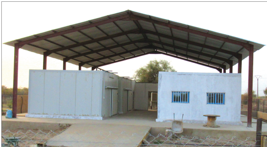
Chambre froide, SIPA Thiambé
